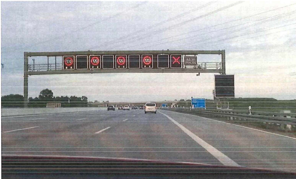
Abb. 5a: Der rechte Seitenstreifen kann während der Stoßzeiten durch Ampeln zeitweise geöffnet werden. Da die Verkehrsdichte zum Zeitpunkt der Aufnahme gering war, ist der Seitenstreifen gesperrt (6/2022: Autobahn A99 bei Unterföhring, Bayern).
