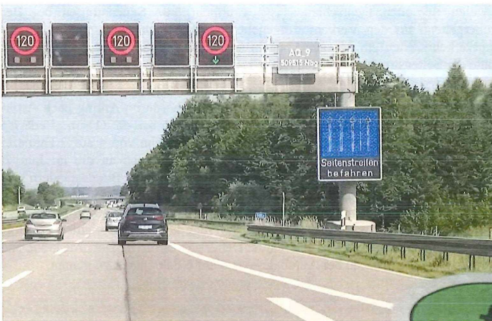
Abb. 5b: Das blaue Verkehrszeichen auf der rechten Straßenseite weist auf die Möglichkeit hin, den Seitenstreifen zu benutzen, was zum Zeitpunkt der Aufnahme vorübergehend durch die Überkopfanzeige mit einem Tempolimit erlaubt ist (6/2022: Autobahn A9 bei München, Bayern).
