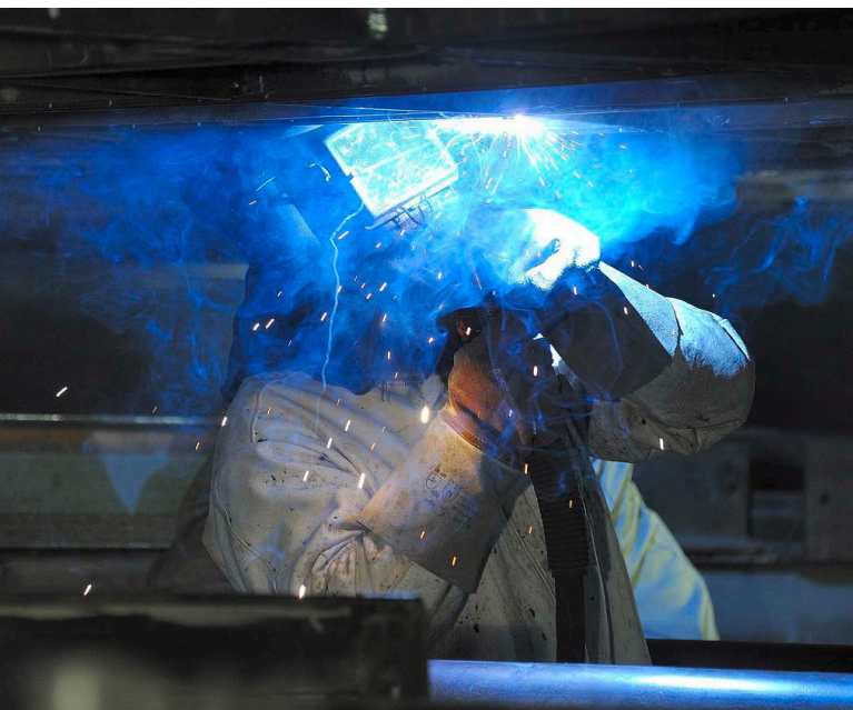
Rauchentwicklung bei Schweißarbeiten
