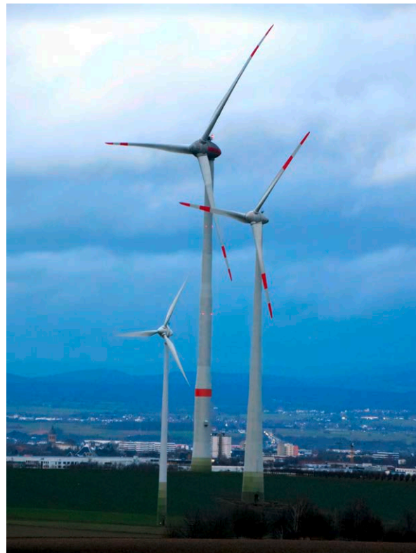
WEAs Hechtsheim: Drei Generationen von Windenergieanlagen (von klein nach groß: E-40, E-82, E-141)
