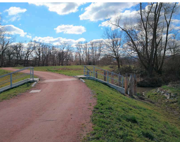
Wegdurchlass mit integriertem Drosselbauwerk
